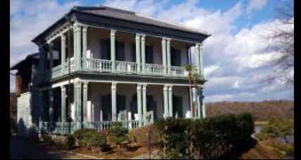
・宗教大学事寄 /旧所在地 東京都豊島区西巢鴨 建設年代 明治41年(1908)
