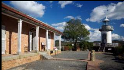
・神戸山手西洋人住居 /旧所在地 神戸市生田区山本通 建設年代 明治20年(1887)代
