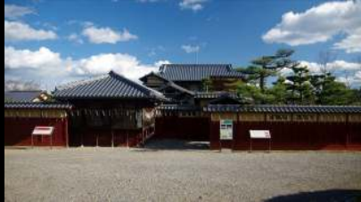
・品川燈台(重要文化財) /建設年代:明治3年 と菅島燈台附属官舎(重要文化財) 列強の不平等通商条約の一貫で建てられた灯台。
