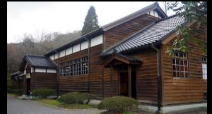
・名古屋衛戍病院(愛知県有形文化財) /旧所在地 名古屋市中区三の丸 建設年代 明治11年(1878)
