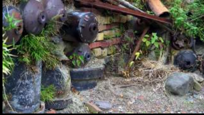
使わなくなった煙突に自生したツルが紅葉している。
